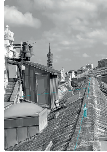
Vérification de la solidité de la charpente après conception de potelets sur mesure de lignes de vie antichute sur les toits de la MAIRIE DE TOULOUSE , place du CAPITOLE .
