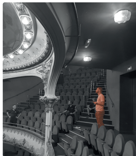
Diagnostic des risques de chutes pour les interventions des éclairagistes du THÉÂTRE DE LA VILLE DE CASTRES .
